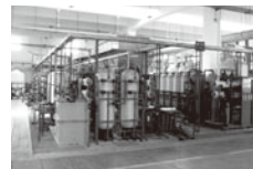
排水処理設備
