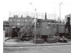
排水処理設備
