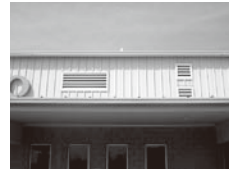
屋根部吸入・排気口を閉鎖
