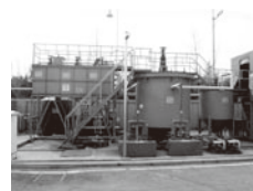
排水処理設備
