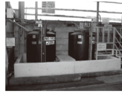
本社工場 対策事例 (廃液流出防止の防液堤)
