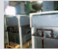
ボイラー写真
