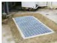
雨水終末口を3槽化
