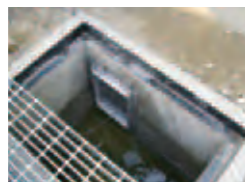
槽内に遮断弁を設置
