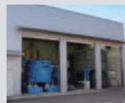
新築した建屋
