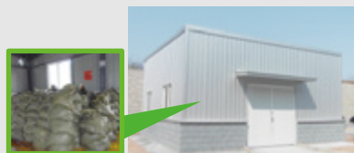
新設した汚泥置き場
