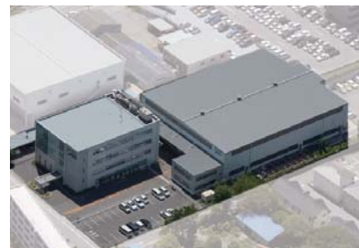
日本ガasket(株)本社本館(手前)と開発棟(奥)
