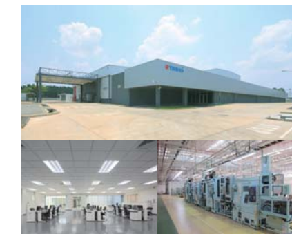
稼働間近のタイハウコーポレーション オブ タイランドの新工場
