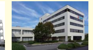
技術開発センター改装('12/5)
