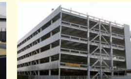
細谷立体駐車場建設('12/1)
