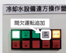
冷却水設備 遠方操作盤
