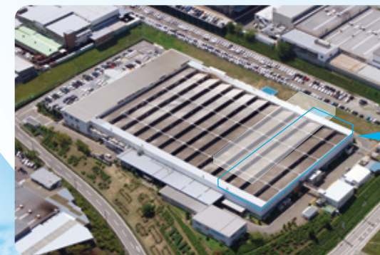
篠原（ささはら）工場内に「篠原BASE」を新設
