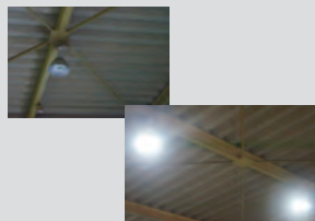
新たに設置した照明
