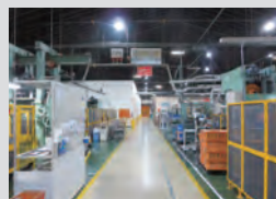
LED化された工場内
