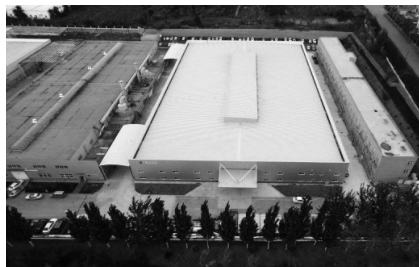
TCY 第3工場 竣工
